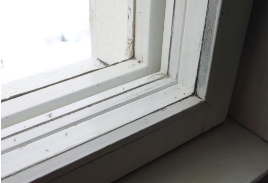
1970-luvulta peräisin oleva 3-lasinen MSK-ikkuna
